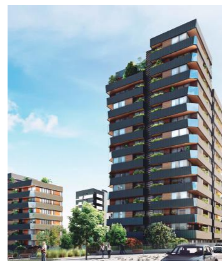
Foto: Viviendas Valdebebas - Ortiz León Arquitectos
