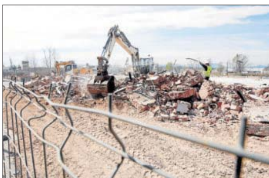
Obres d'enderroc i construcció de la Clínica. MARC MARTÍ
